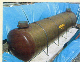
4. 固定バンド取付(40m³長尺)
