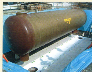
3. 製品設置(40m³長尺)
