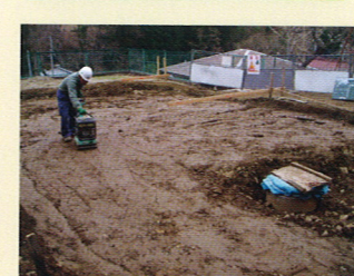
7. 埋め戻し転圧
